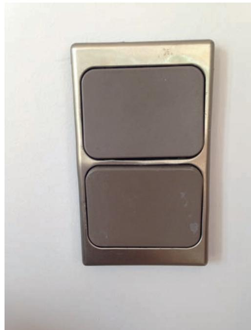
**Fig. 10-9** Interrupteurs contrastés.
